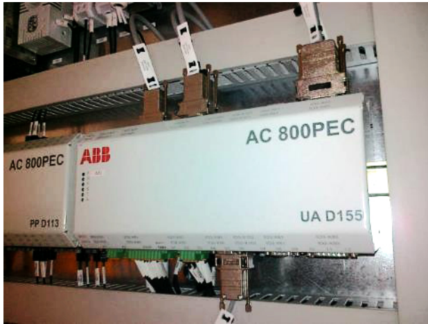
Figure 8-4 AC 800PEC Combi IO UA D155
